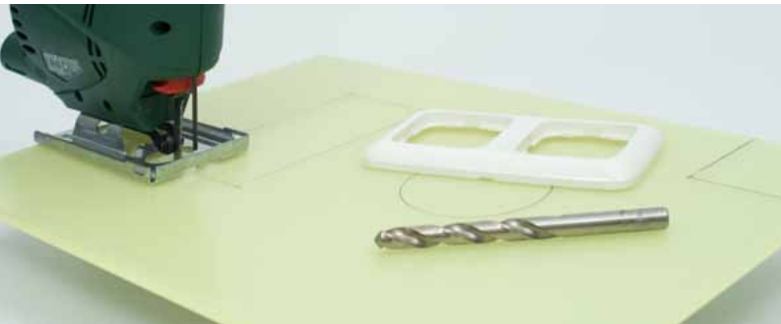
Aussparungen und Öffnungen in den Schnittkantenecken stets vorbohren und mit einer Stichsäge oder Oberfräse herausarbeiten.
