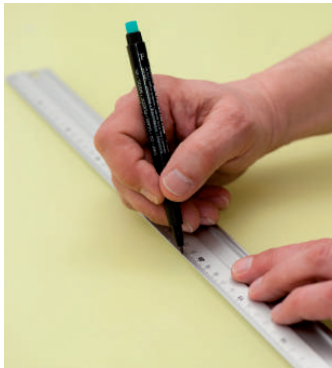
Aussparungen und Öffnungen auf der Folie anzeichnen und in den Schnittkantenecken stets vorbohren.
