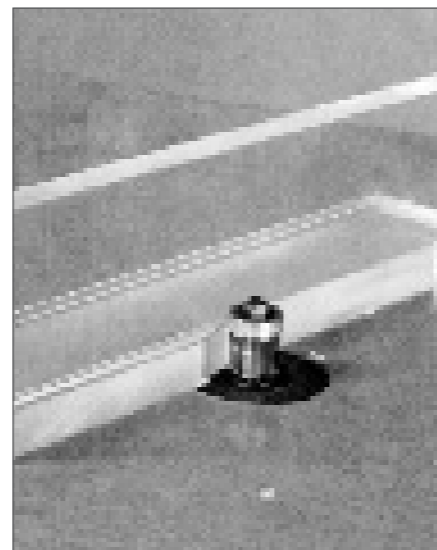
Abb. 21: Abfräsen von Klebewülsten
