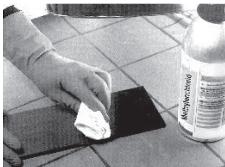
Abb. 13: Chemisches Nachbehandeln einer vorgeschliffenen Oberfläche
